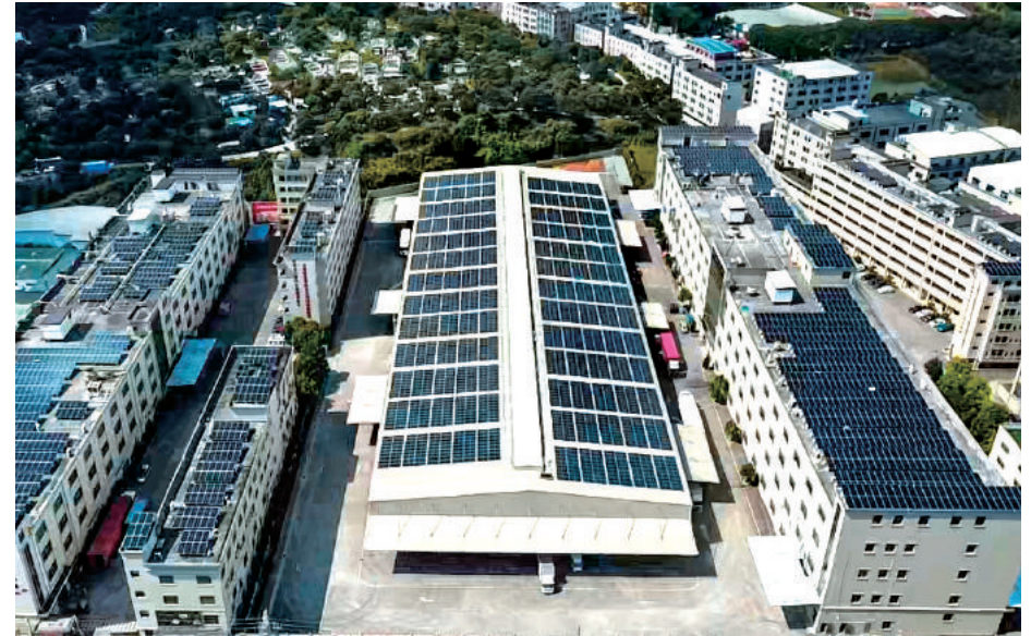
广东新盟食品有限公司 2.186MW 屋面分布式光伏电站，东莞市 Guangdong Xinmeng Food Co., Ltd. 2.186MW Roof Distributed Photovoltaic Power Station, Dongguan
